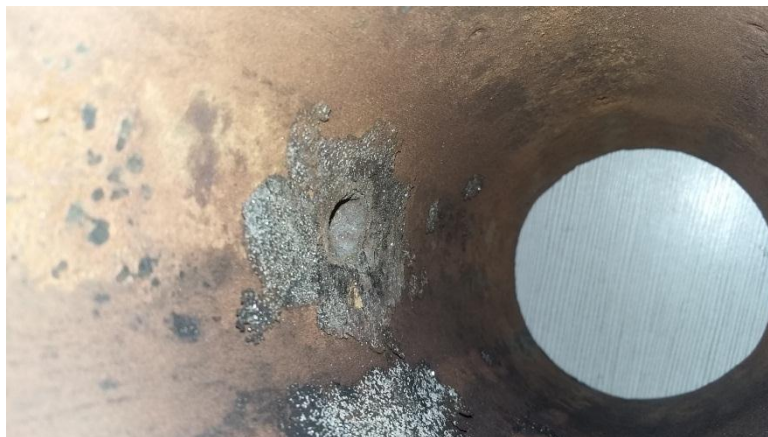
Рис. 2. Образование питтинга на внутренней поверхности участка трубопровода
