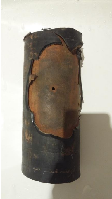
Рис. 1. Общий вид участка трубопровода
